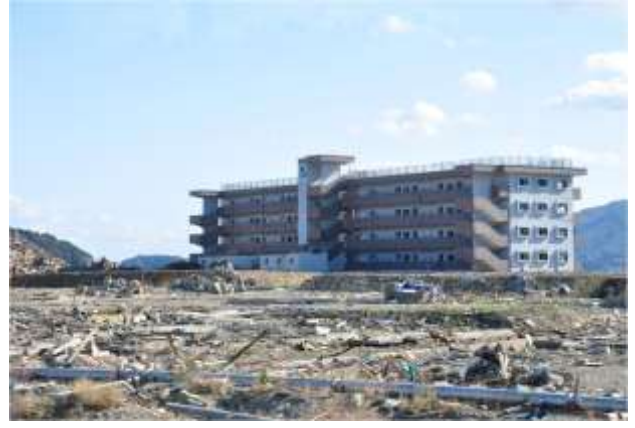
写真-5-4 津波に襲われた時の志津川病院 (2011年10月) 建築 研究所国際地震工学センター撮影
