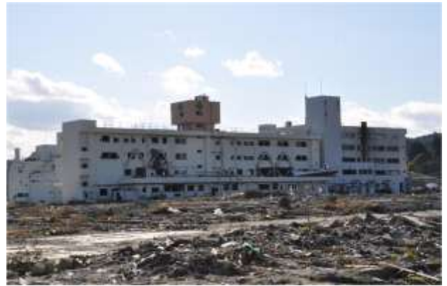
写真-5-5 南三陸町 志津川病院 裏手より (2011年10月) 建築 研究所国際地震工学センター撮影
