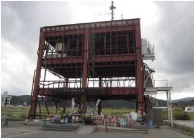
写真-2-1 南三陸町の防災対策庁舎
