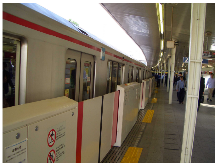
写真-1-1 丸ノ内線のホーム柵
