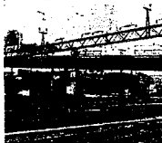
写真一 改良工事途中のベルン駅
