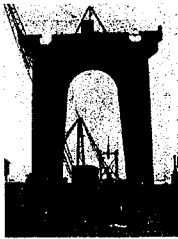
写真二 新フォー思ブリッジ建設工事
