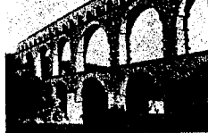
写真5 Bédarride 塔の水塔
