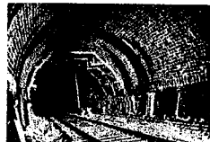
写真-10 ベルギー-国鉄トンネル改良工事(移動セメント使用)
