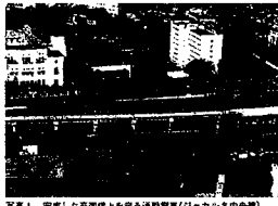
写真1 完成した高速度上を走る高速電車(ジャカルタ中央駅)
